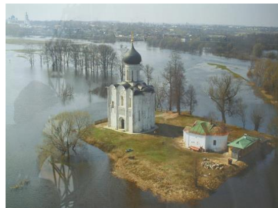
Церковь Покрова на Нерли
